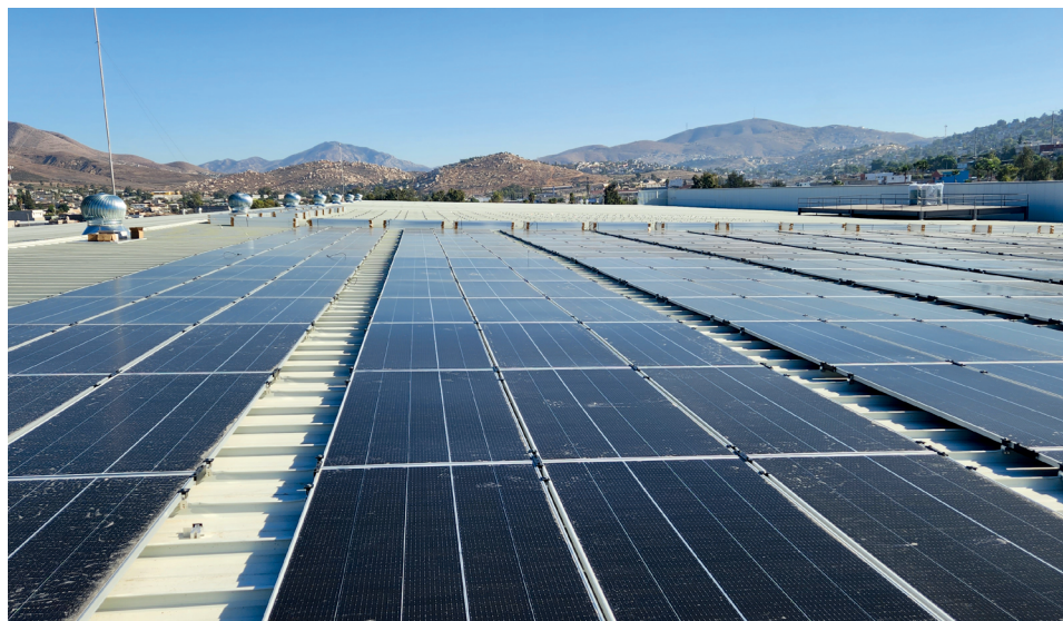
멕시코 생산법인 태양광 설치 모습
